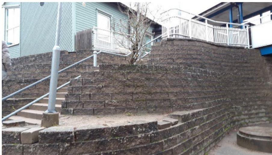
Det finns stenar i stödmuren som sitter lösa på olika ställen sedan länge. Det är farligt, eftersom stenarna är stora och tunga.
