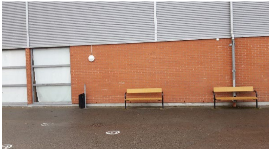
Bänkarna på bilden är placerade mot väggen för att begränsa att barnen använder väggen när de spelar tennis eller vid annan bollek. Möjligheterna att använda ytan är redan begränsad. Barnen använde väggen ändå fast bollarna som träffar bänkarna studsar ibland iväg utan kontroll.
