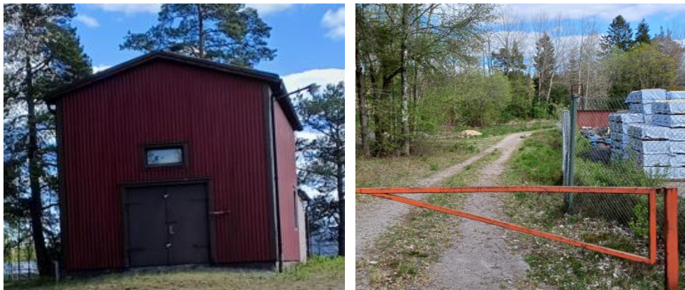
(Vänster) Mottagningsstation, dvs. el-stationen (Höger) Grusvägen längs industriområdet med bom.
